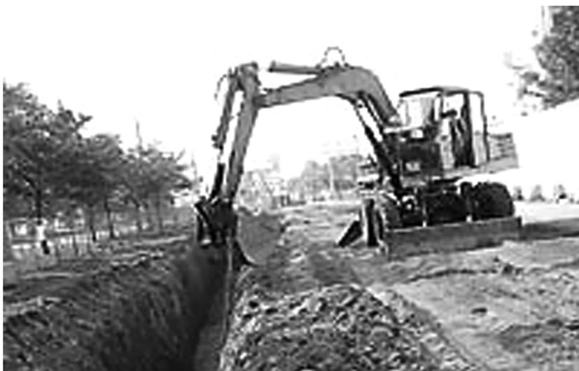
*Рис. 21. Раздельный способ прокладки трубопровода*
