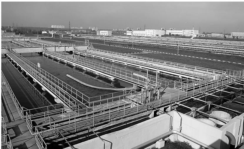
*Рис. 32. Блок удаления биогенных элементов очистных сооружений*
