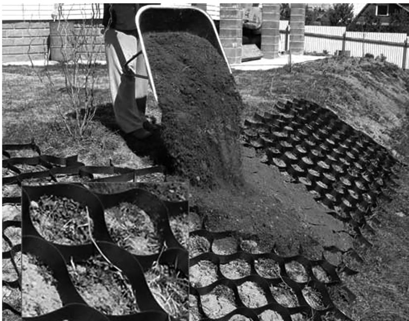
*Рис. 16. Укрепление грунтового откоса*
