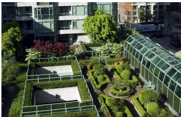
Рис. 2. Крыша, выполненная интенсивным способом озеленения
