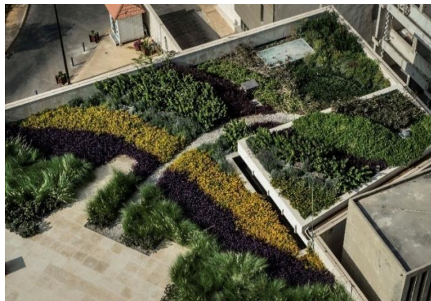
Рис. 4. Крыша, выполненная полуинтенсивным способом
