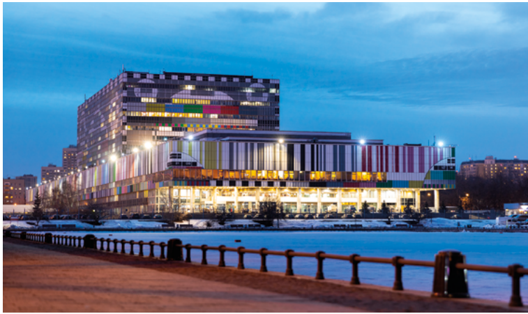
Телевизионный технический центр «Останкино» (фото А. Сивова, 2024 г.)
